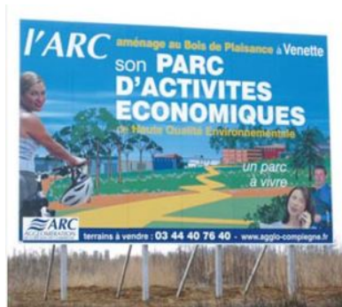
Panneau 24 m² en 8 éléments verticaux, pose sur supports 140 x 80 mm et jambes de force.
